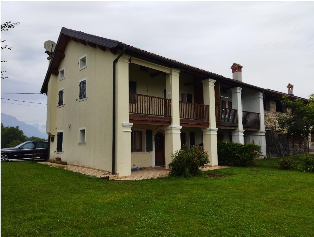
Fronte interno SUD OVEST
