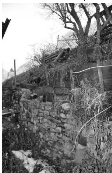
Foto 22 – L'area scoperta sul retro
