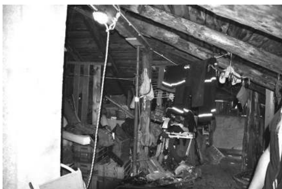
Foto 87 – 88 – Il sottotetto adibito a soffitta
