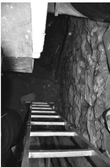
Foto 23 – L'accesso con scala a pioli
