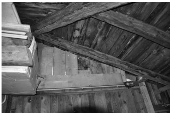
Foto 89 – Il sottotetto adibito a soffitta
