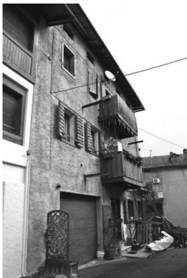
Foto 3 – vista dalla strada
