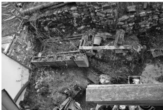
Foto 18 – L'area scoperta sul retro
