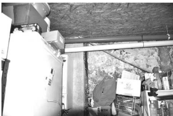
Foto 39 – il locale deposito
