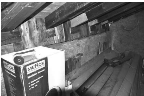
Foto 85 – 86 – Il sottotetto adibito a soffitta
