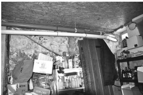
Foto 40 – il locale deposito
