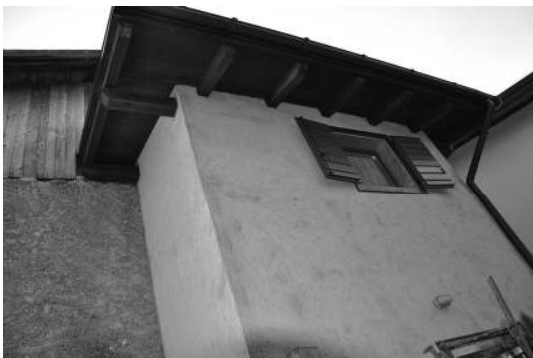
Foto 6 – Il volume aggiunto sul retro
