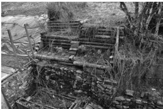
Foto 17 – L'area scoperta sul retro
