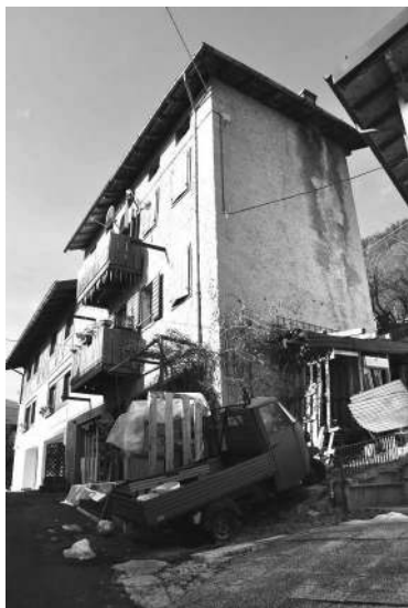
Foto 1 - Vista dalla strada
