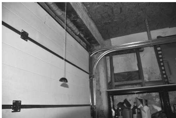
Foto 34 – Dettaglio del portone del garage
