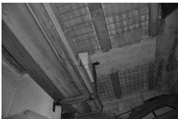
Foto 37 – Il soffitto della cantina
