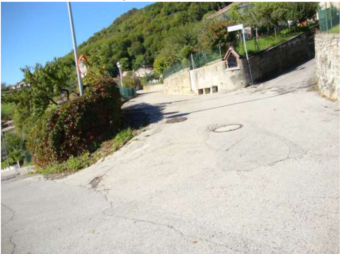
Fig. 15 – vista della via G. Verdi
