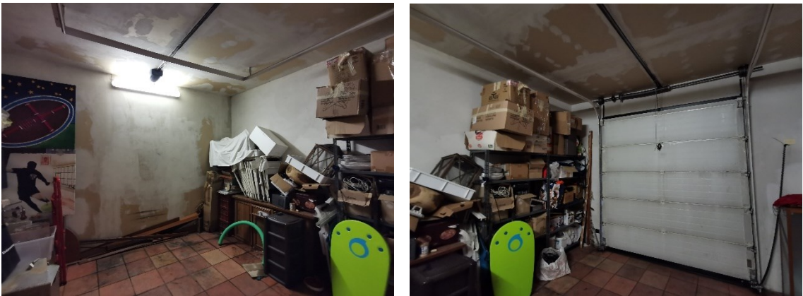
Fig. 19 – Panoramiche interne al garage
