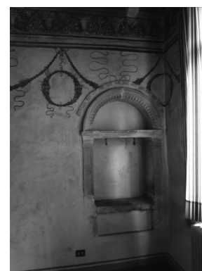
Particolare salone piano secondo
