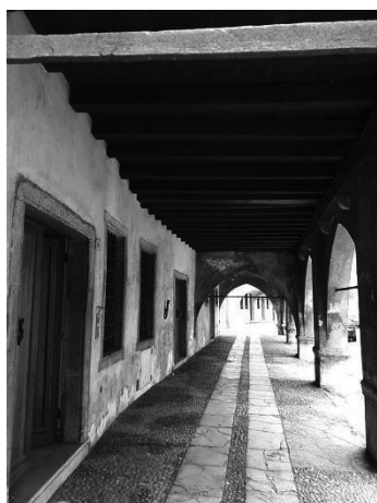
Portico con portoni d'ingresso
