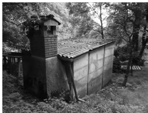
Fabbricato part. 338 lato nord
