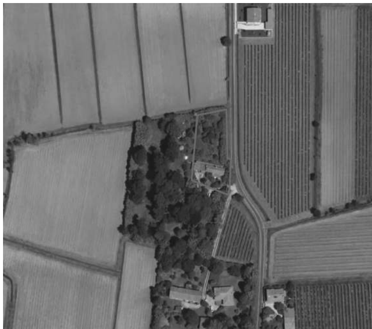
Fig. 1 – Foto aerea particella n. 146 comprendente i fabbricati
