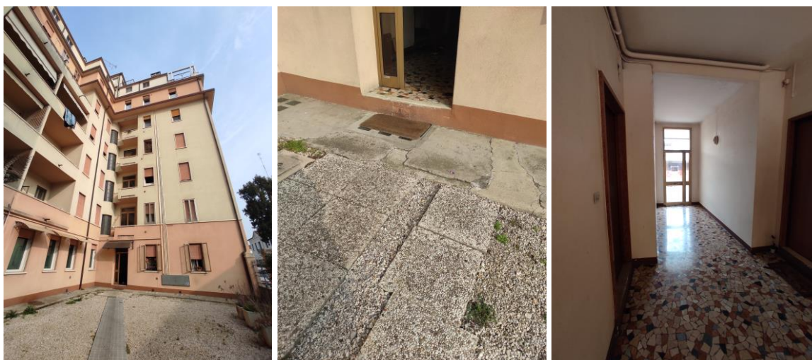
Porzione nord del fabbricato, ingresso comune
