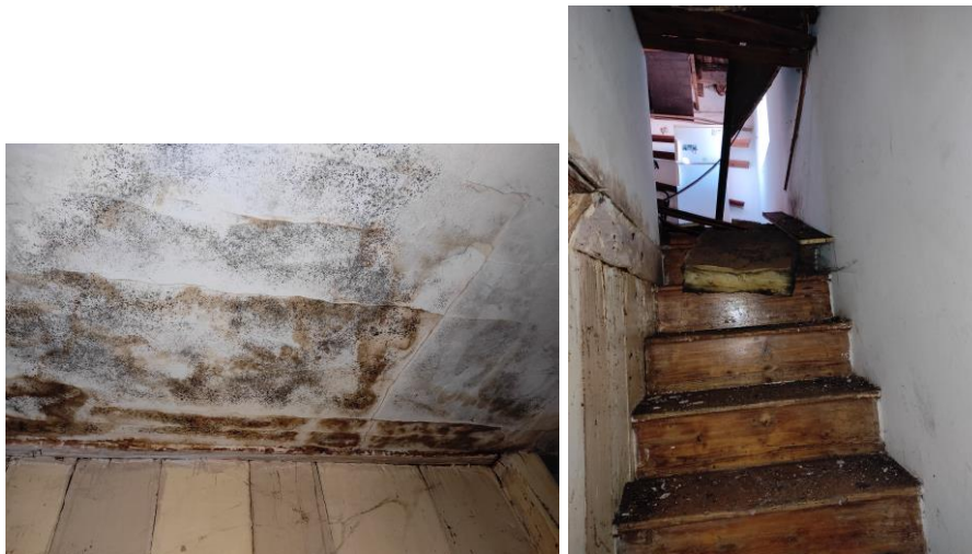
Ingresso unità (particolare intradosso solaio) e scala in legno
