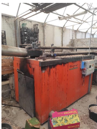
Caldia e serbatoio esterno
